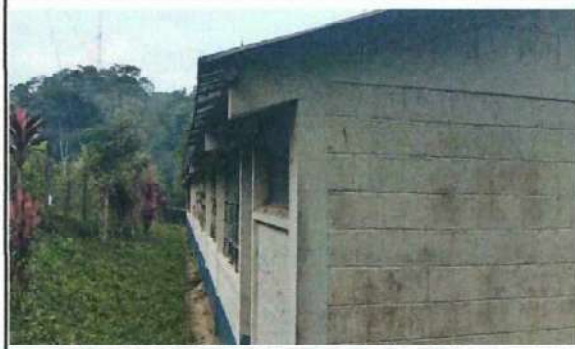
Foto 2: Paredes exteriores para pintar
