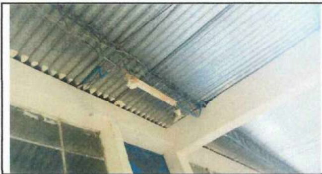
Foto 5: Cambiar estructura metalica por costanera metal
